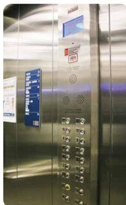
Botoeiras de cabina e pavimentos com design moderno, em aço inox escovado, indicador eletrônico de pavimento e botões braille.
